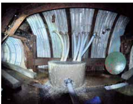
排水トンネル工により集められた地下水 〔磐井川地区（ニゴリ沢）〕
