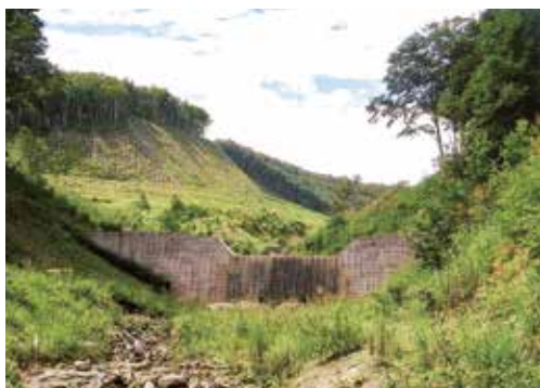
荒廃溪流復旧のために施工された溪間工及び山腹工 〔迫川地区（耕英冷沢）〕
