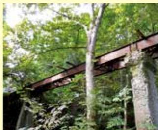
小田川支線に残る鋼製ガーター橋
