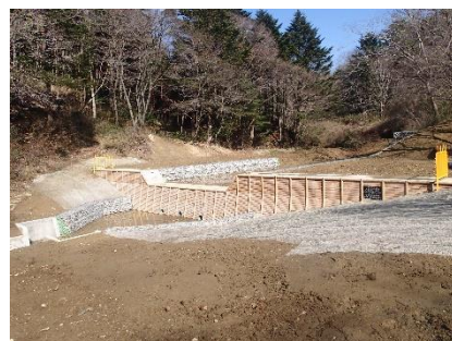
【床固工（仙台市太白区）】
