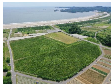
【海岸防災林（東松島市）】
