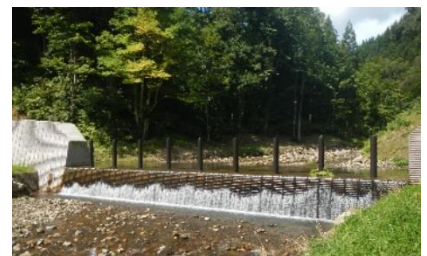
【治山ダム（北秋田市）】
