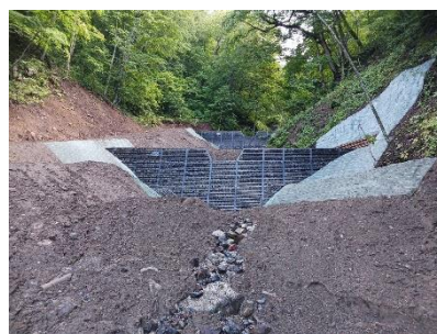
【鋼製棒谷止工（十和田市）】
