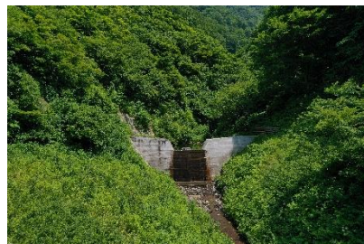
【コログ沢木製型枠堰堤（東成瀬村）】
