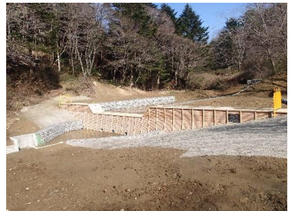
【床固工（仙台市太白区）】
