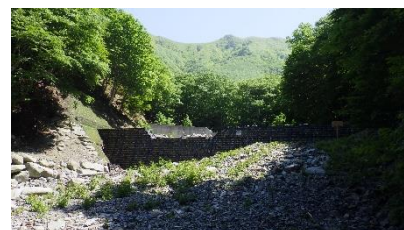
【枯松沢治山施工地（釜石市）】
