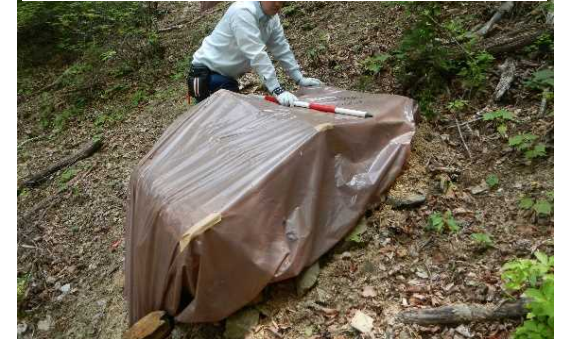
薬剤散布状況
