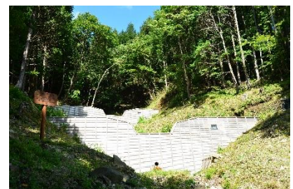
【治山ダム（遠野市）】
