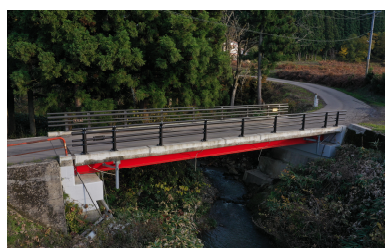
元西馬音内林道改良工事
