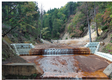
大赤川災害復旧治山工事
