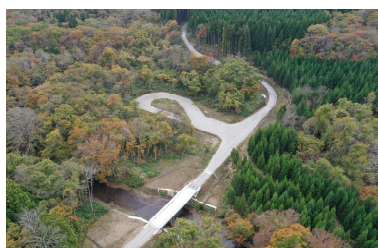
二又林道改良工事
