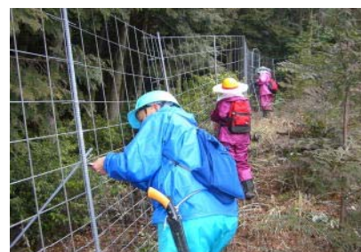
シカ防護柵点検補修
