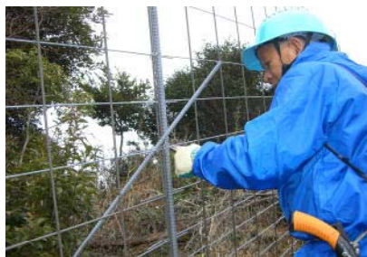
シカ防護柵点検補修
