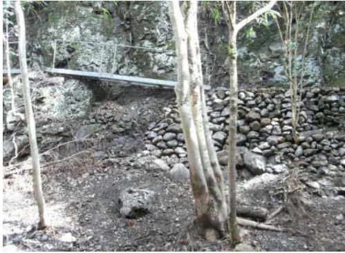
遊歩道修繕完了
