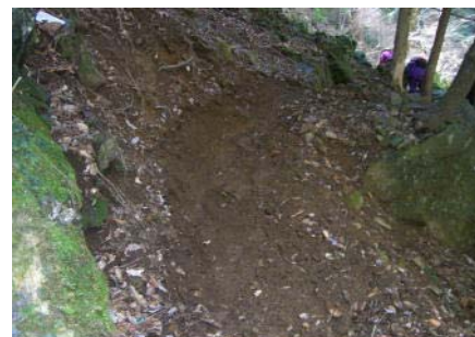
登山道修繕完了
