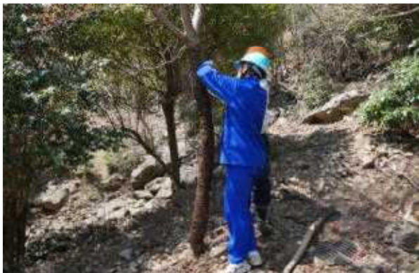
ラス巻き作業の様子
