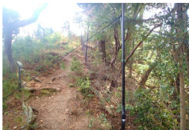
設置したシカ防護ネット
