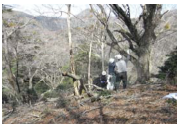
シカ防護ネット設置中
