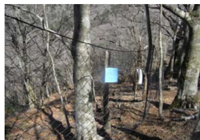
シカ防護ネット設置完成
