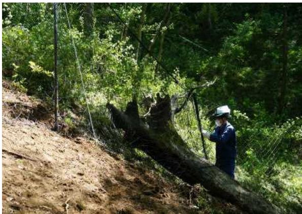
壊れたネット柵の補修作業の様子
