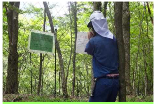
ネット柵に雷注意看板の設置
