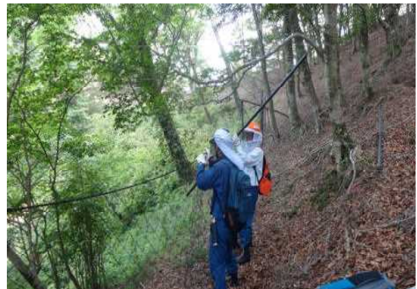
落ち葉の堆積で弛んだ柵の補修作業
