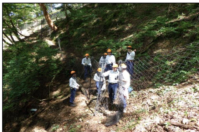
最後に入出口を増設して完了
