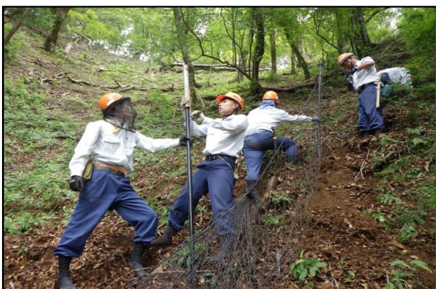
支柱再建と張り直し
