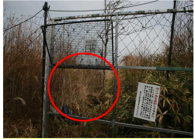
改良前のゲートを開けた状態
