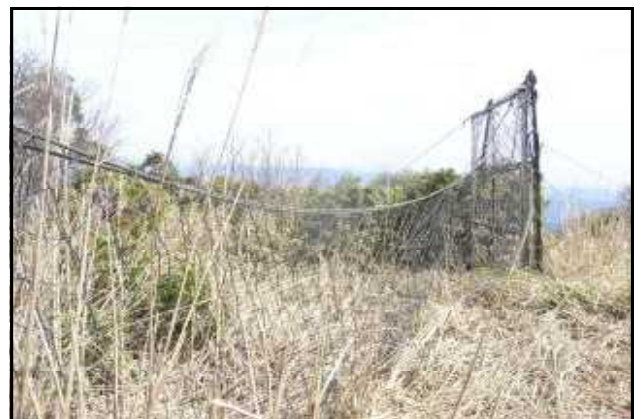
三本杭のコース内で修理した柵
