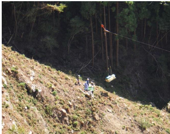
集材架線を利用してツリープロテクター、支柱等資材を運搬
