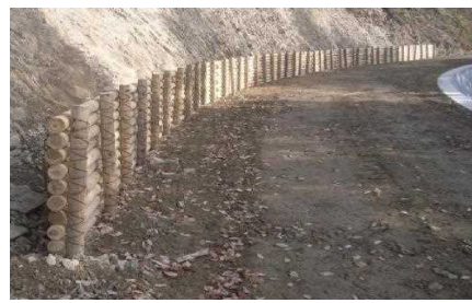
林道に施工した木柵工（香川所）
