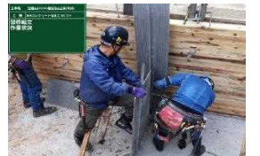
谷止工の型枠に県産木材を利用 (安芸署)
