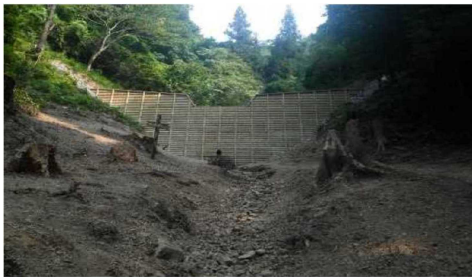
木製残存型枠を使用した谷止工（愛媛署）
