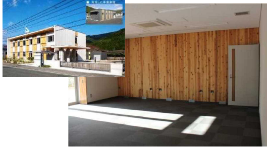
国で初めてCLTを本格活用した額北森林管理署庁舎（平成30年完成）
