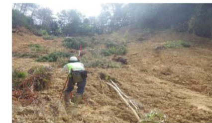
山地災害対策緊急展開チームによる測量作業(高知県大豊町)
