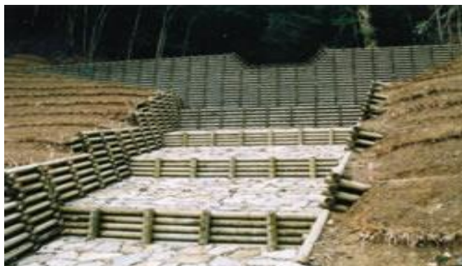
木製型枠を使用した谷止工(愛媛署)
