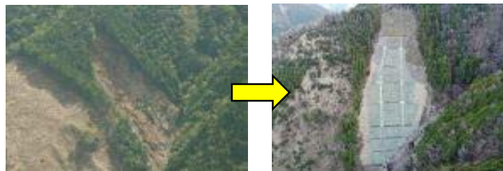
土留工による荒廃地の整備(高知中部署)
