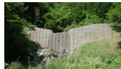
間伐材を利用した治山ダム工(嶺北署)
