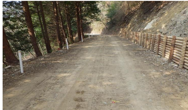
林道に施工した木柵工(香川所)
