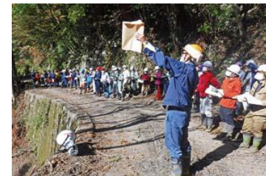
架線系作業システム現地検討会(愛媛署)
