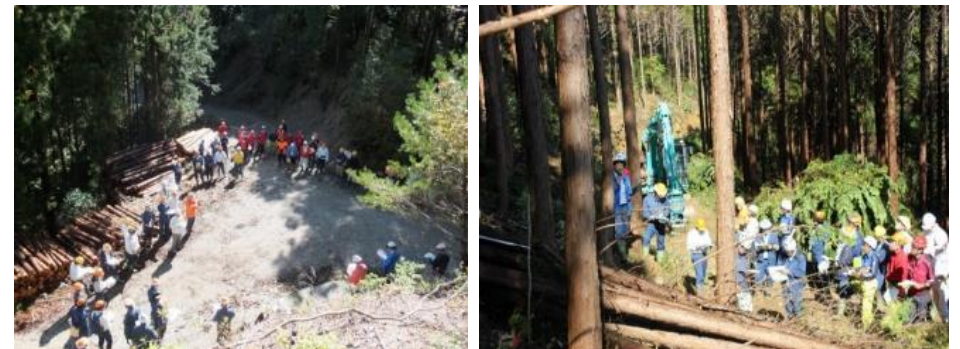
令和元年度 列状間伐現地検討会（中ノ川国有林）
