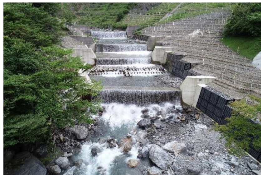
治山事業による災害復旧 (ひかり石91林班)
