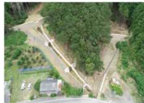
治山事業による崩壊地の復旧
