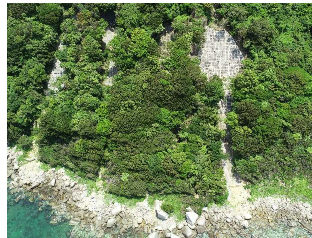
治山事業による崩壊地の復旧
