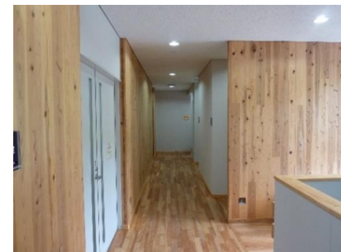
CLT内壁と床サクラ材(2階)
