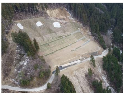
復旧状況(山腹工施工状況)
