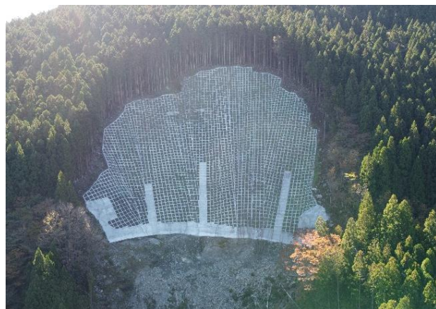
山腹工施工状況（大豊町仁尾ヶ内）
