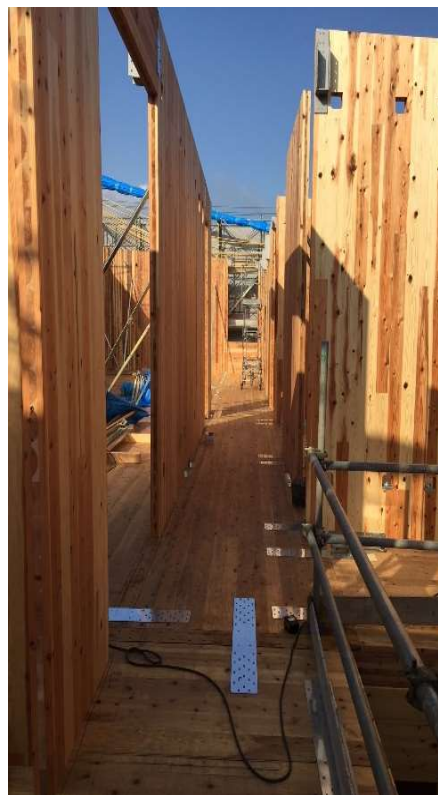
CLTの使用状況(2階)
