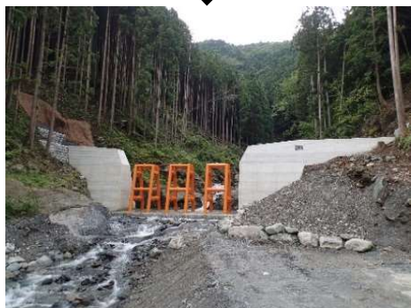
復旧状況(崩壊下流部対策工)
