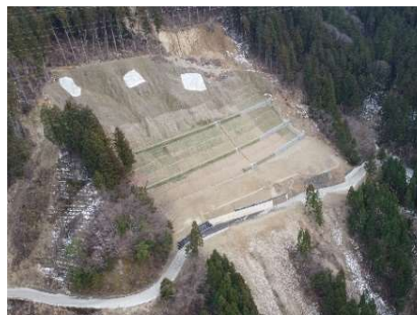
復旧状況(山腹工施工状況)
