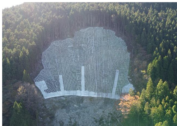
山腹工施工状況（大豊町仁尾ヶ内）
