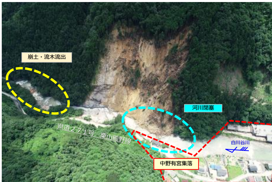
崩壊発生時（平成30年7月撮影）
