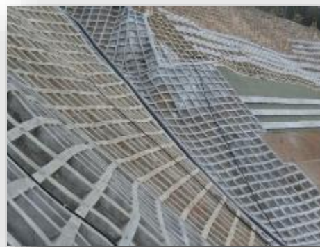
現場吹付法枠工
