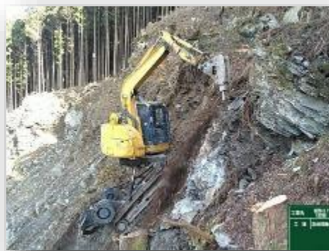
高所斜面法切工
