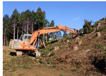
機械地拵の状況
