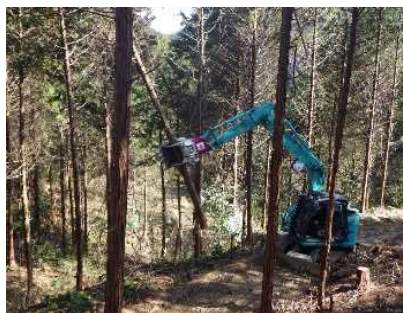
高性能林業機械（ハーベスタ）による間伐（香川所）
