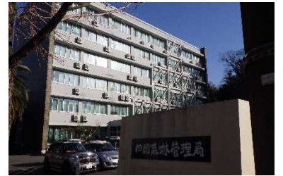
現・四国森林管理局庁舎
