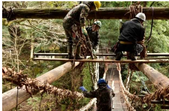
祖谷のかずら橋・架替作業中
