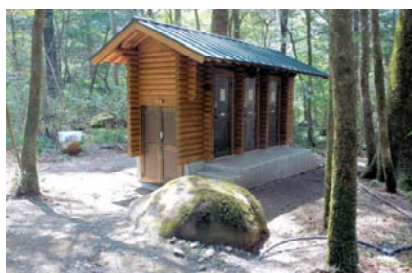
改修されたバイオトイレ
