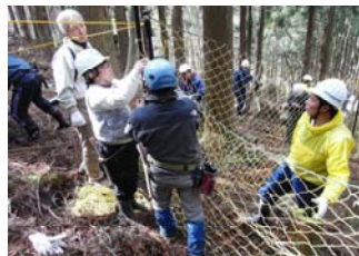
植生保護柵の設置状況
