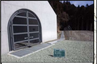
排水トンネル工(沖区域)
