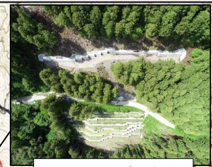
アンカー工(沖区域)
