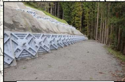
アンカー工(西峰区域)
