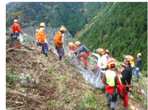
▲高知県立林業大学校へのシカネット設置実習
