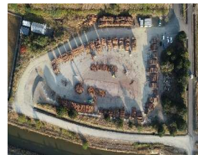
▲令和2年度に整備した竹島土場（高知県四万十市）
