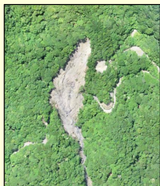
ドローンで撮影し、高解像度オルソモザイク画像作成処理ソフトによりオルソ画像化。
