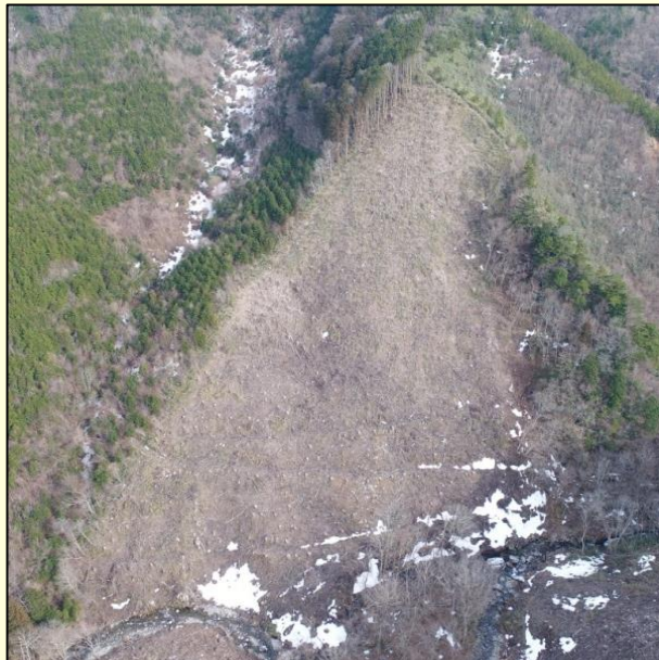
作業開始前(平成30年3月にドローンで撮影)
