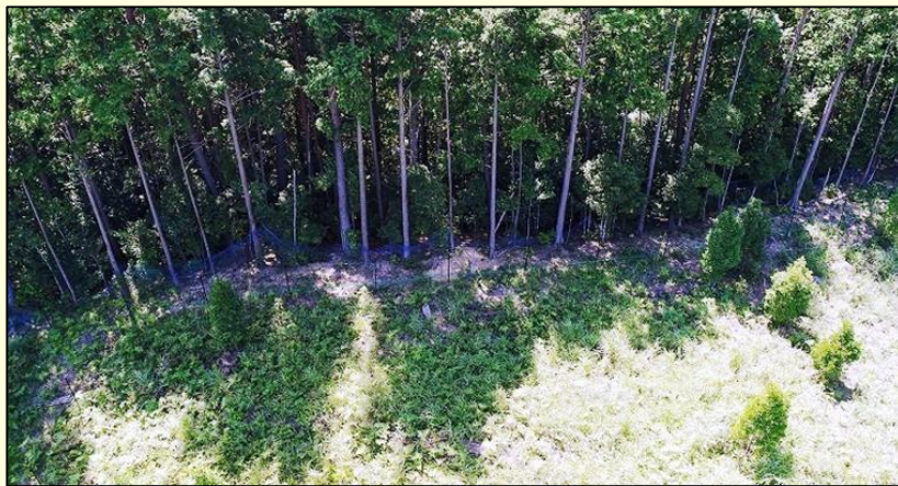
ドローンにより防護柵を確認。
