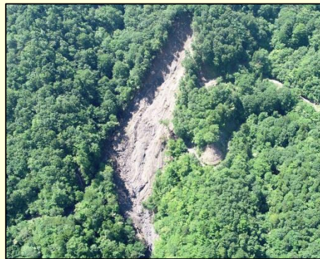
ドローンによる上空からの撮影により、全体の被害状況の確認が可能。
