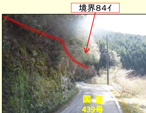
巡視簿の添付写真(現地確認)
