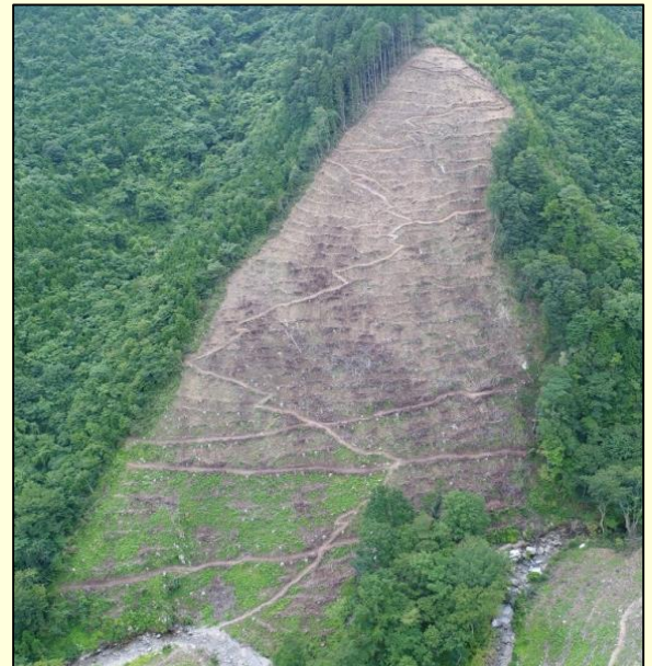
作業後(平成30年7月にドローンで撮影)
