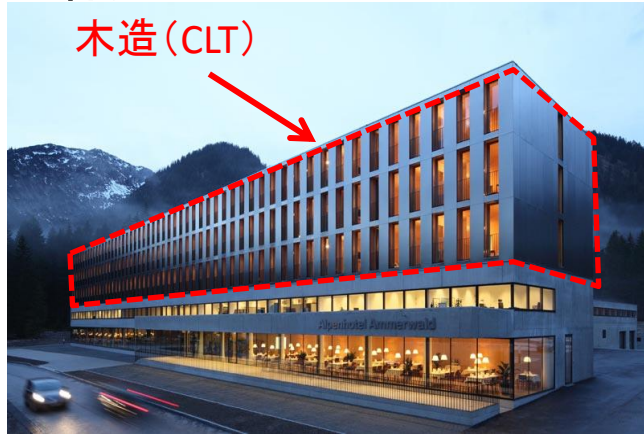
BMWグループのホテル (オーストリア) 1~2階:RC造 3~5階:木造 (CLT)
