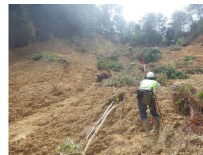
測量作業の様子(愛媛県大洲市)
