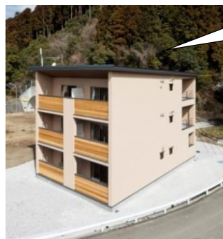
CLT建築物国内 第1号(高知県)
