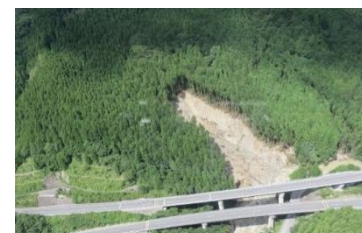
大豊町立川上名の被災現場
