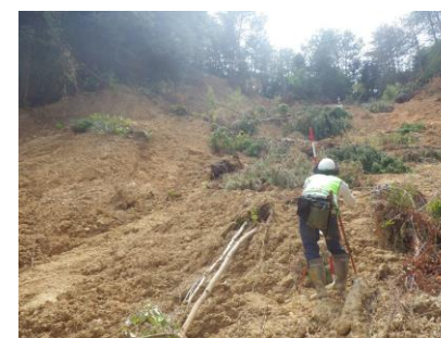
測量作業の様子(愛媛県大洲市)
