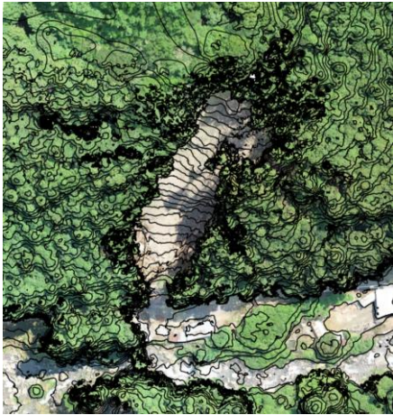
徳島県上勝町の被災現場のオルソ画像 (H30.7.15 徳島森林管理署)
