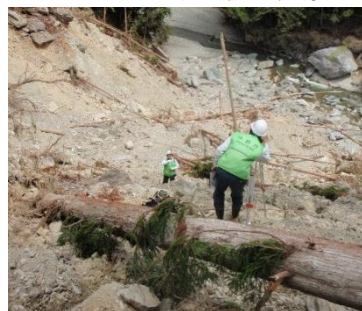
測量作業の様子(高知県大豊町)
