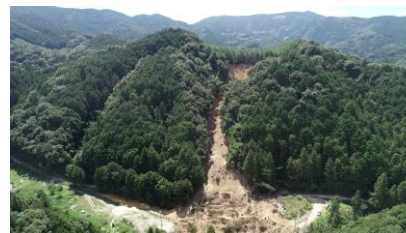
大洲市平野町の被災現場
