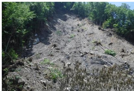
地上からの撮影は視点が低いため、全体の被害状況の確認は難しい。
