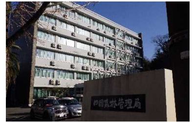
現・四国森林管理局庁舎
