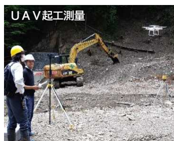
ICT施工(掘削工)
