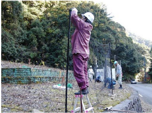
ニホンジカ防護ネット設置
