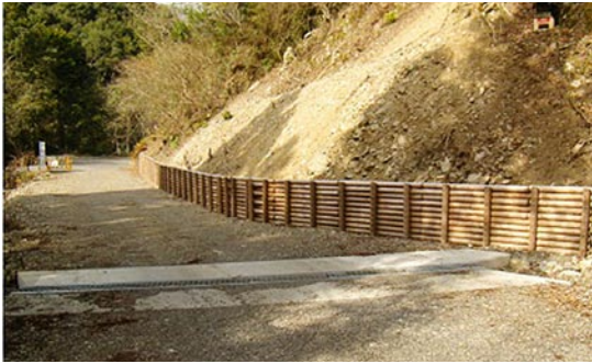
林道に施工した木柵工（高知県四万十町）
