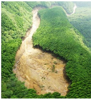
奈半利川地区崩壊地全景
