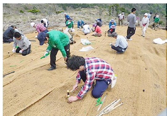
ボランティアによる植生回復用ネットの設置
