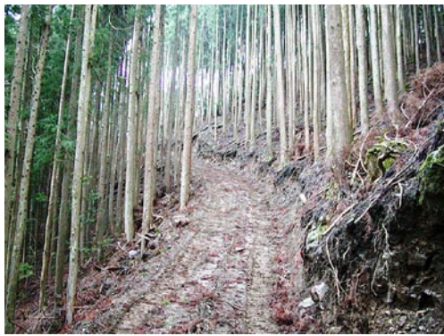
森林作業道の開設
