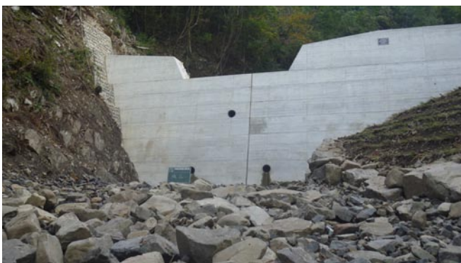
国有林内の谷止工施工状況
