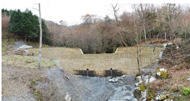
溪流荒廢地に木製残存型柵を使用し施工した谷止工
