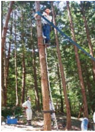
先柱ガイドライン設置
