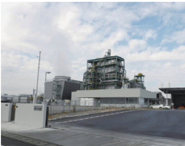
バイオマス発電所（徳島県阿南市）
