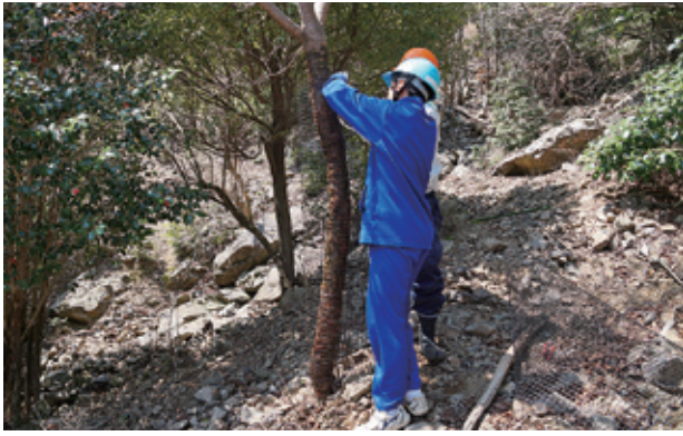
ラス巻き作業の様子
