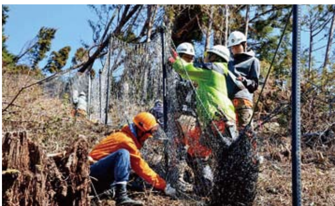
現地実習：シカネット設置を実施中の署員と学生
