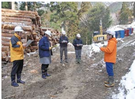
現場視察の様子
