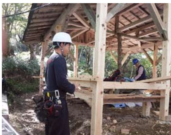
補修中の東屋の様子
