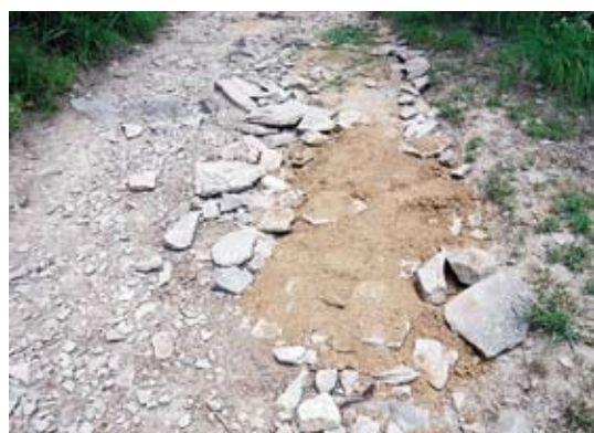
「一日一石運動」で修繕された歩道
